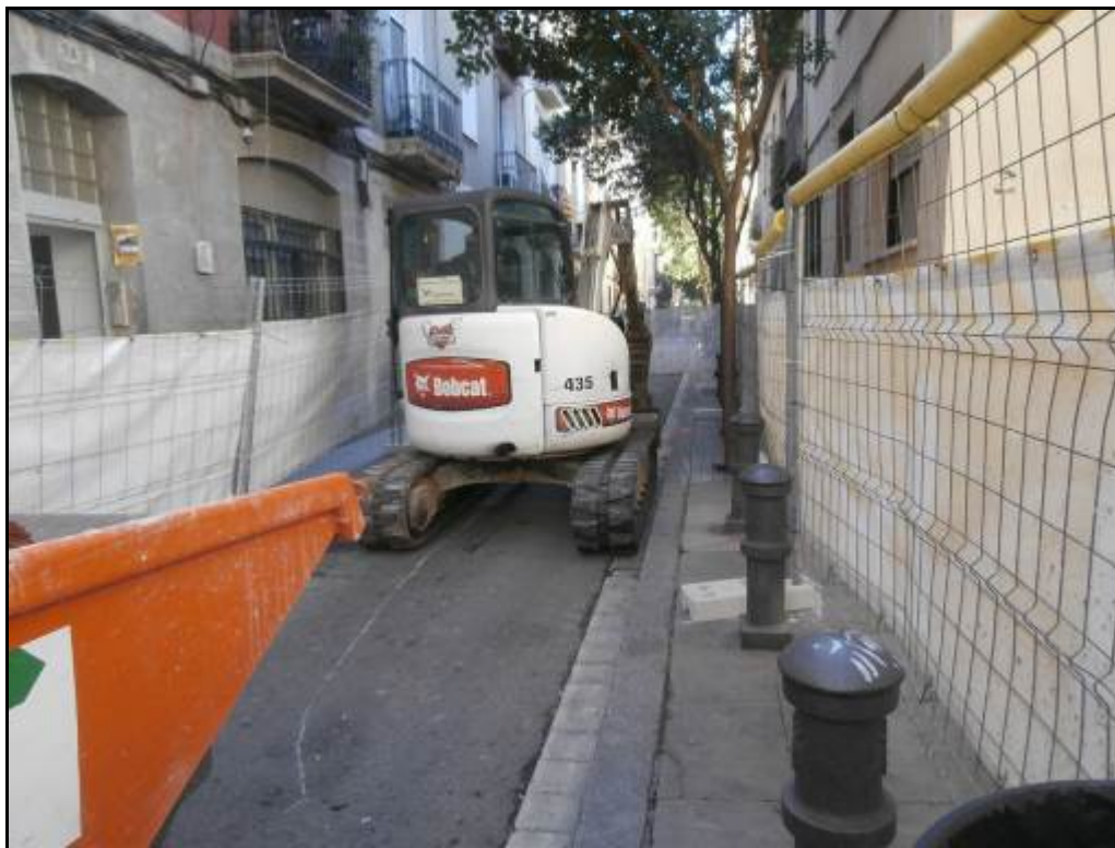
Fotografia 12: Inici de l'obertura de l'embornal 2, davant el nº 19B del carrer Tordera.
