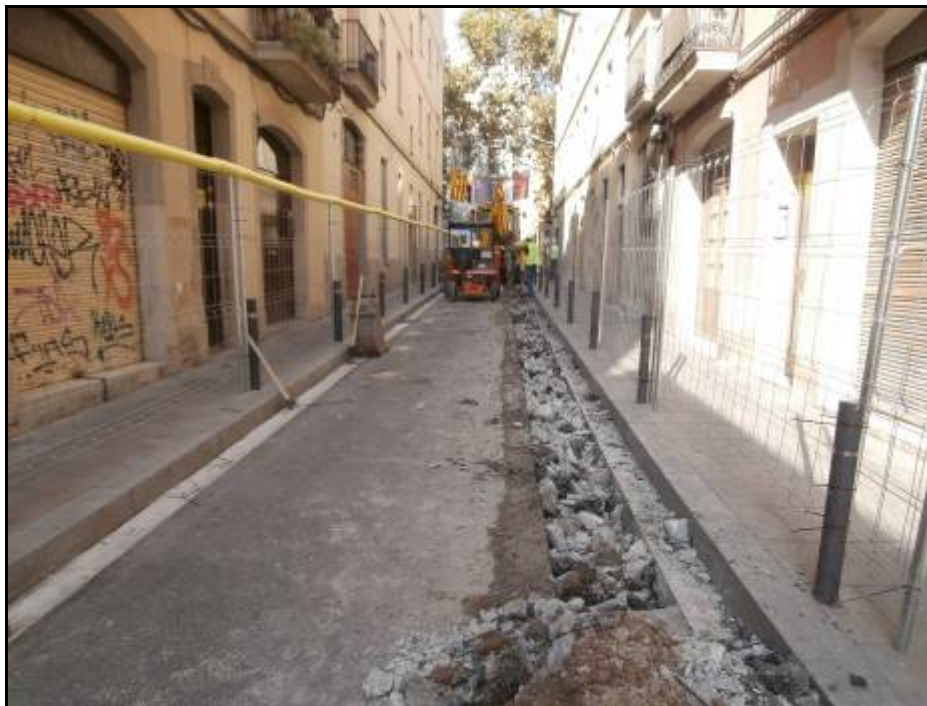
Fotografia 2: Trencament del paviment al carrer de Tagamanent.
