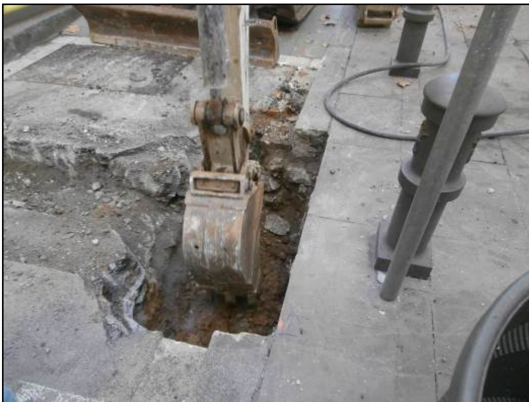
Fotografia 16: Buidament amb màquina de la cala de l'embornal 3, al carrer de Tordera.
