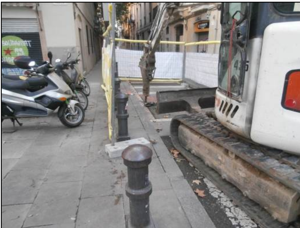
Fotografia 15: Inici cala de l'embornal 3, al carrer de Tordera.
