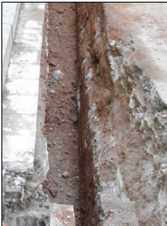
Fotografia 6: A la dreta, paret lateral del col·lector que passa pel centre del carrer Tagamanent.
