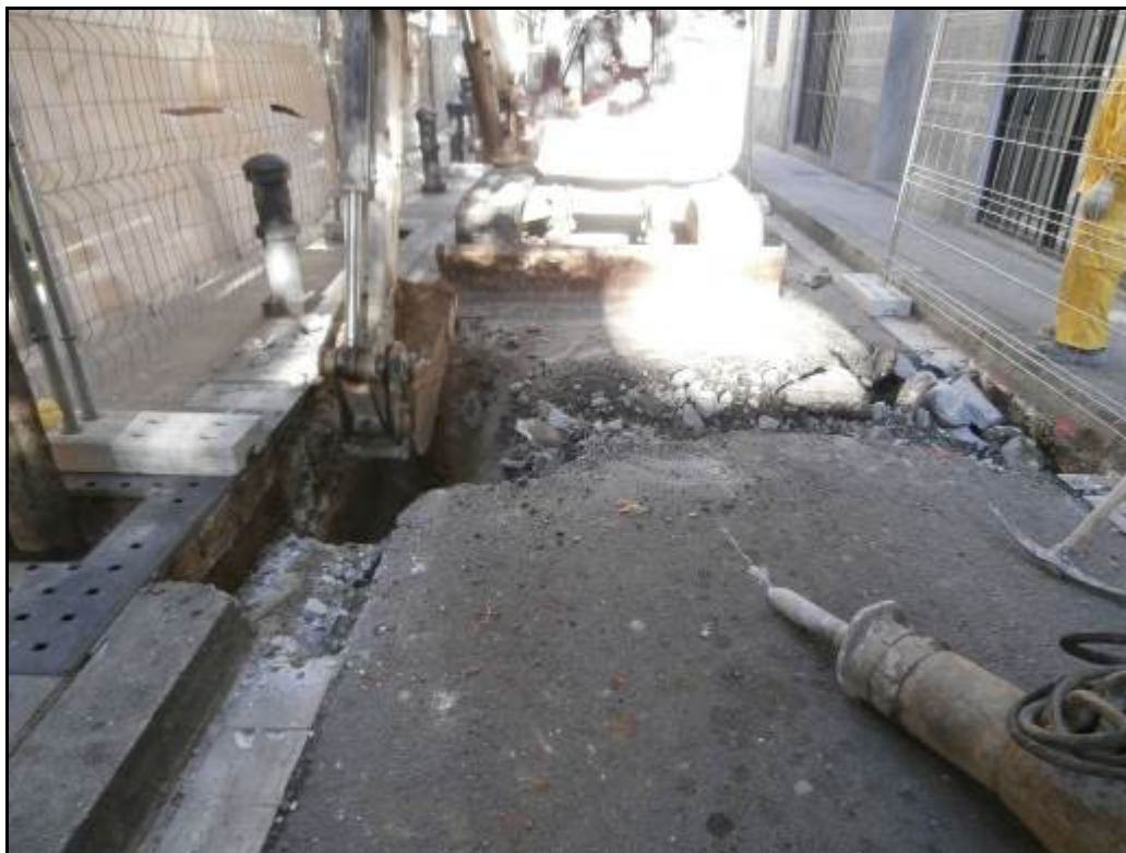
Fotografia 13: Buidament amb màquina de la cala de l'embornal 2, al carrer de Tordera.
