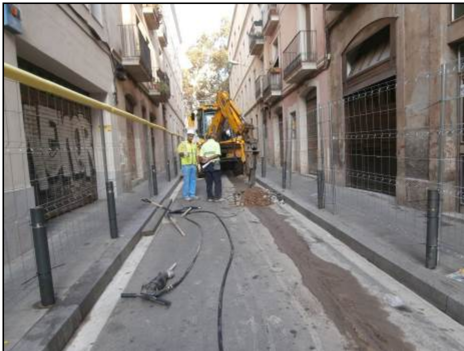
Fotografia 1: Vista general del carrer de Tagamanent, amb la màquina trencant la pavimentació per obrir la rasa d'enllumenat.
