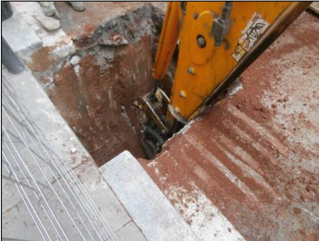
Fotografia 9: Buidament de la cala de l'embornal 1, al carrer de Tagamanent.
