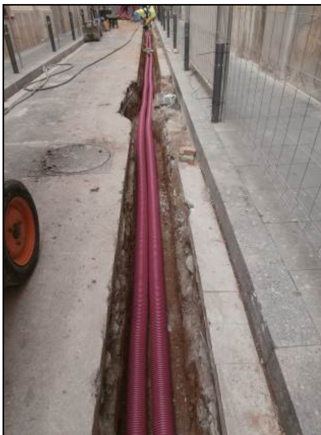
Fotografia 4: Col·locació dels tubs a la rasa del carrer de Tagamanent.
