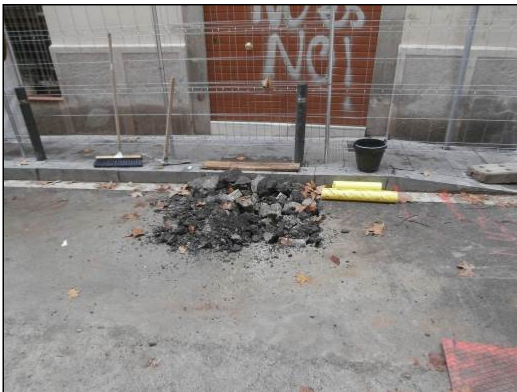
Fotografia 8: Trencament d'asfalt a l'embornal 1, davant el nº 2 carrer de Tagamanent.
